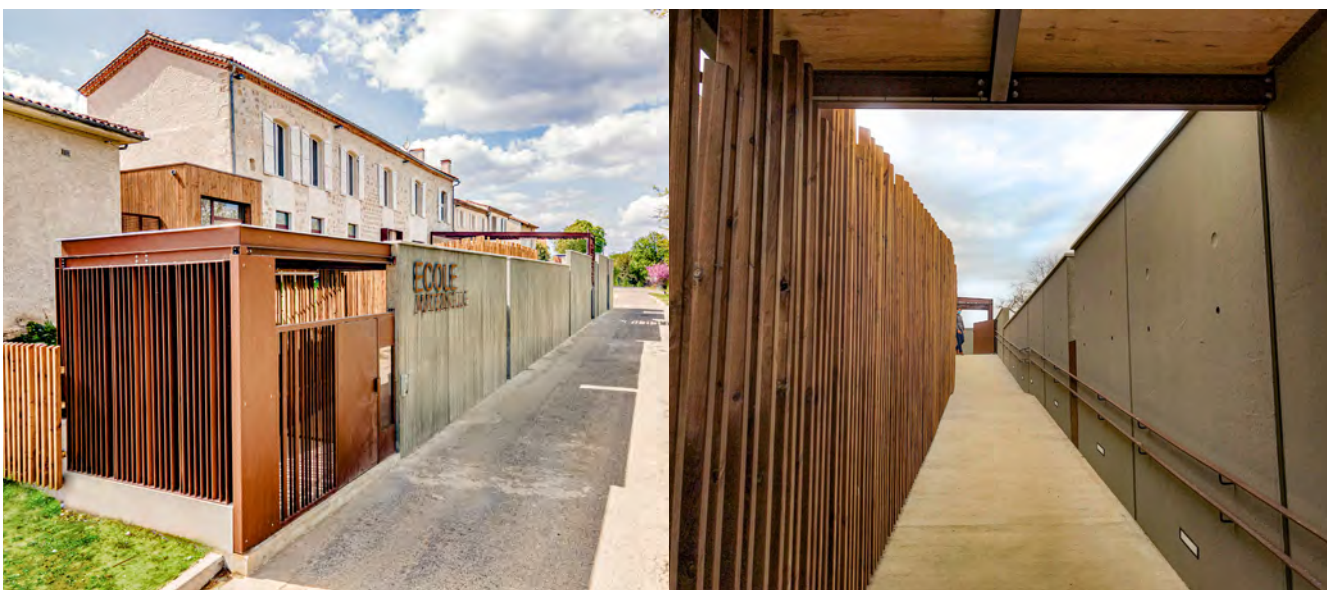
La rampe de l'école permet de répondre aux exigences d'accessibilité tout en constituant une vraie pièce d'architecture, avec un usage de sas. © Agence Airolti architectes
